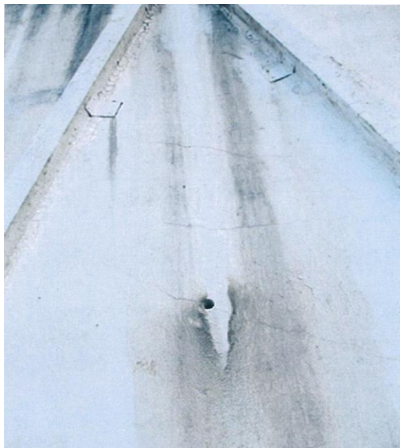
Slika 5: V nekaterih AB polnilnih ploščah so prisotne razpoke.
